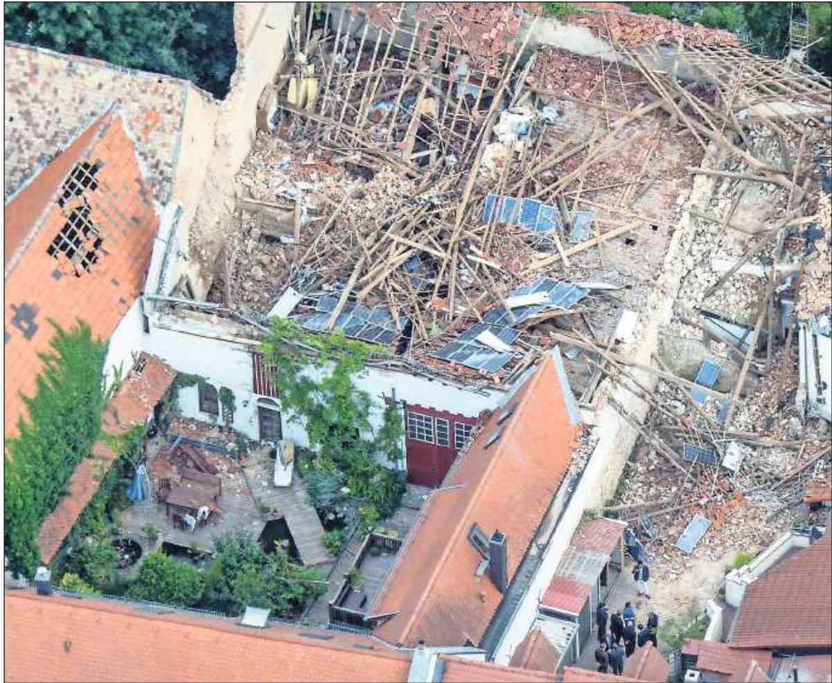
Nur noch ein Trümmerhaufen: Ein Sturm hat am Dienstagabend im rheinhessischen Framersheim Millionenschäden verursacht.
